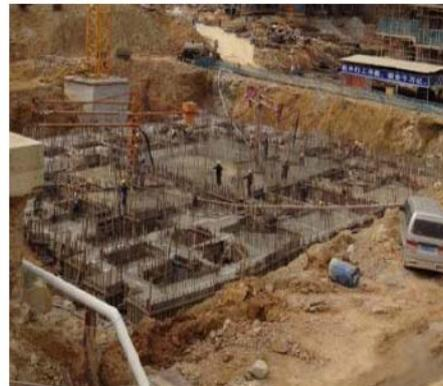
7#栋底板工程栓浇筑施工完成
