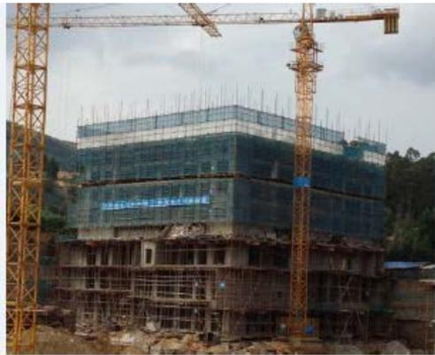
1#栋地上四层混凝土浇筑施工完成
