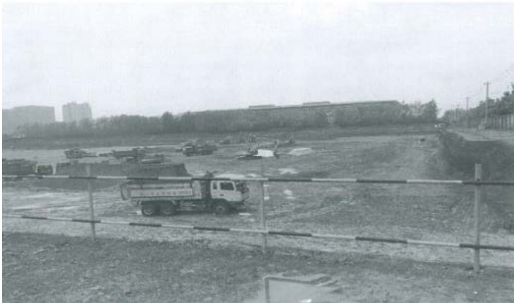
项目现场形象进度-土方开挖约 40 万方
